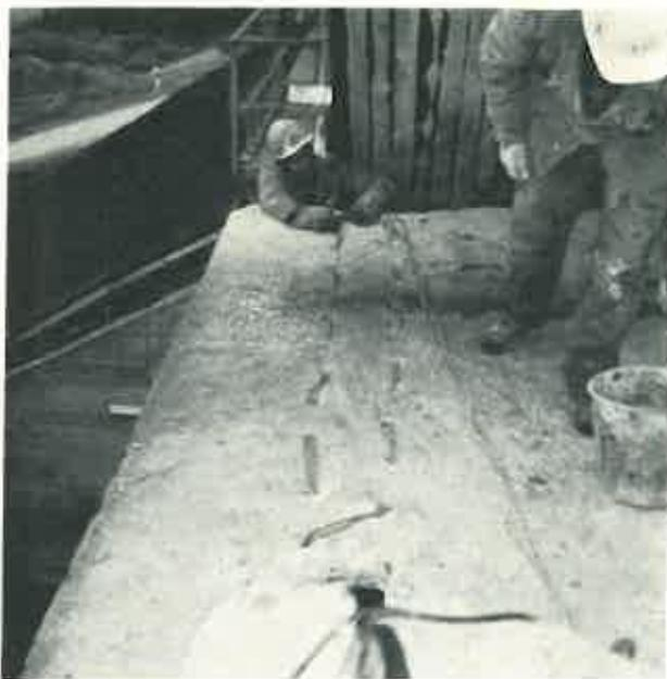
Bild 2. Vorbereitungen zum Absprengen der Decke.
