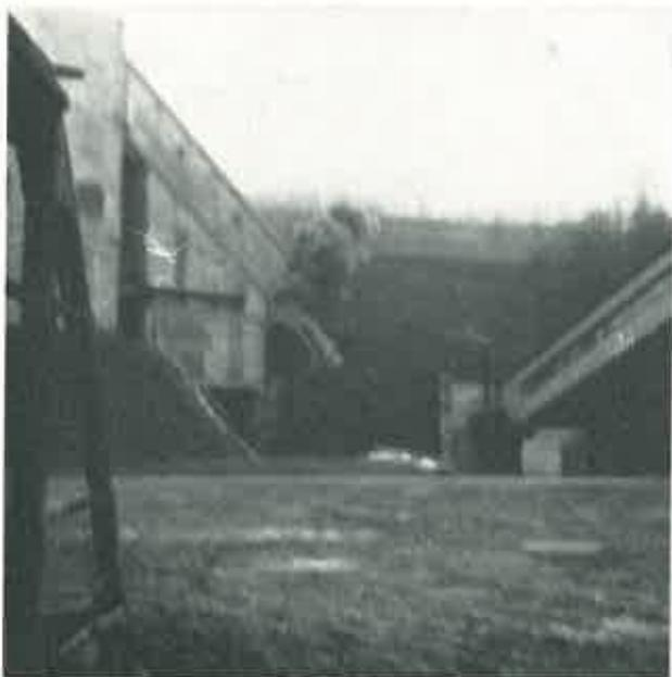
Bild 9. Sprengung eines südlichen Seitenwandteils (Rückwand).
