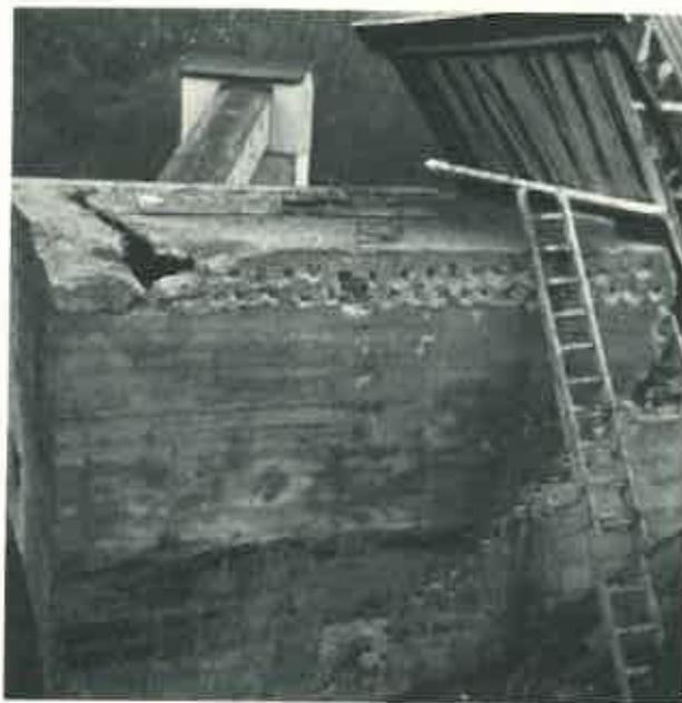
Bild 3. Sprenglöcher an der nördlichen Seitenwand des abzubrechenden Teiles.
