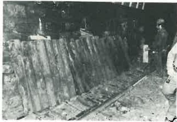
Bild 7. Abdeckung der Sprengstellen.
