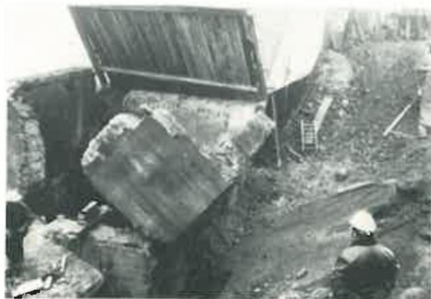
Bild 11. Seitliches Abziehen eines nördlichen Oberteils.
