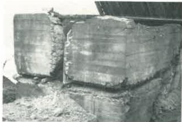
Bild 10. Seitenwände und Kopfwand nach erfolgreichen Teilsprengungen.
