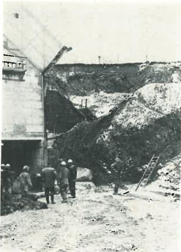
Bild 17. Ergebnis der Spreng- und Räumarbeiten mit dem gut erhaltenen Unterteil des Schachtgebäudes.
