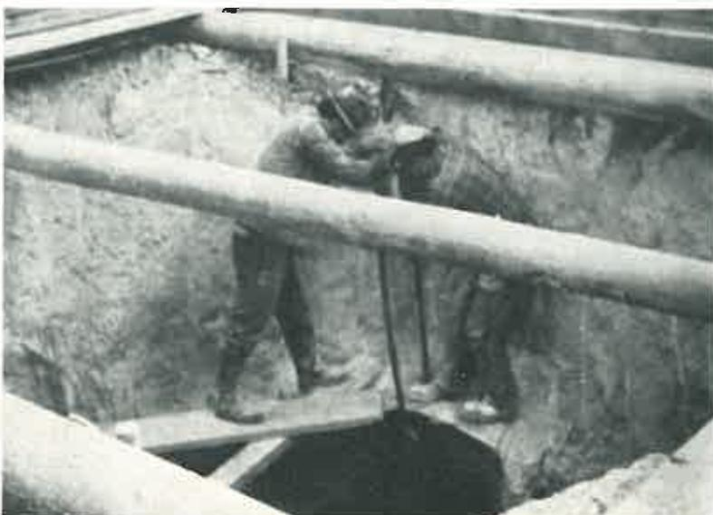
Bild 4. Bohrarbeiten an einem Reststück des Innenmantels.
