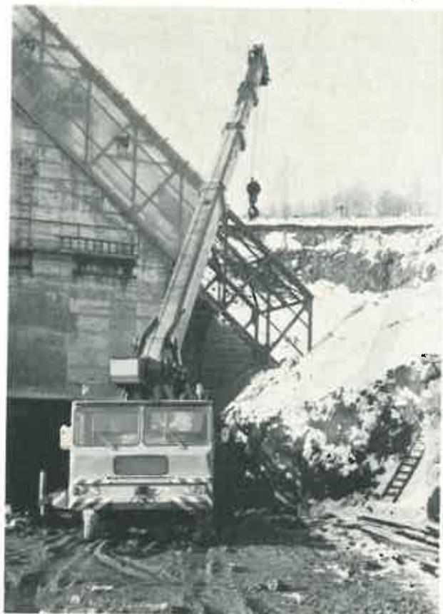
Bild 18. Auflegen der Förderbrücke auf den Unterteil des alten Schachtgebäudes.
