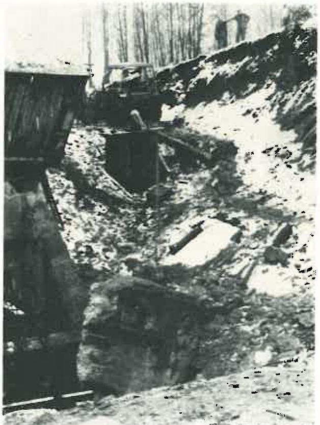
Bild 16. Seitliches Abziehen des letzten nördlichen Oberteils; dahinter die glatte Fläche der stehenbleibenden Betonmauer.
