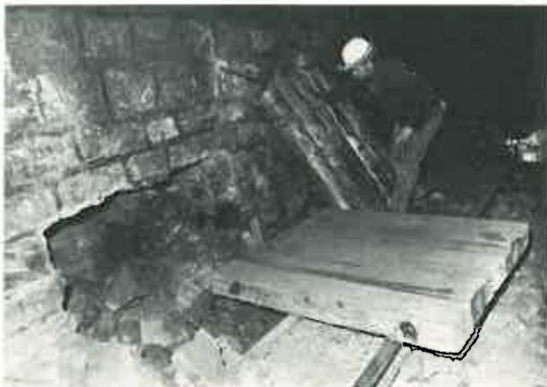
Bild 4. Ergebnis der dritten Versuchssprengung.
