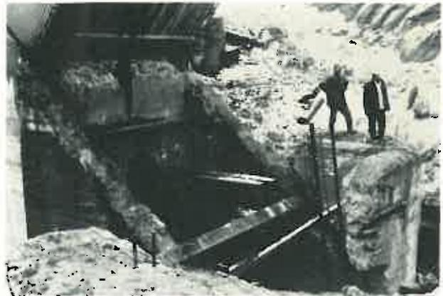
Bild 15. Freigelegter Unterteil des Schrägschachtes ohne Beschädigungen der stehenbleibenden Betonwände.
