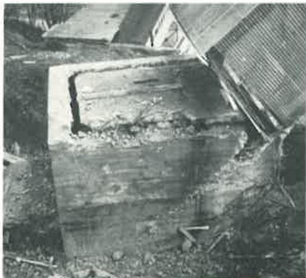
Bild 7. Decke nach dem seitlichen Absprengen.
