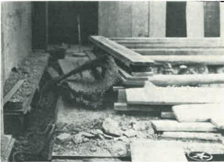
Bild 2. Erschütterungsmeßgerät an der Außenwand des Turbinengebäudes im Vordergrund links; Sprengstelle rechts neben dem Bohlenstapel.
