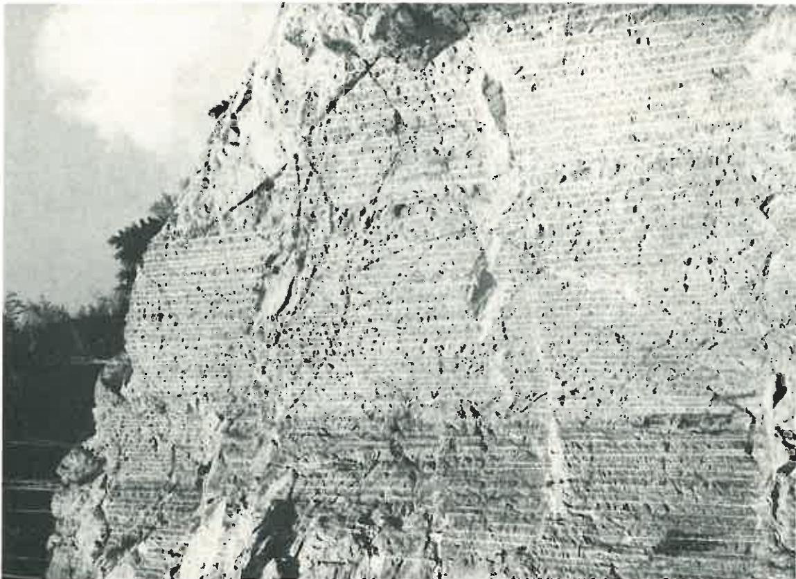
Bild 4. Erkennbares Absetzen der Vorspalt-Sprenglöcher gemäß der jeweiligen Gesteinsblock-Höhe an Querstörungen.
