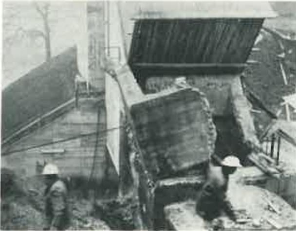
Bild 12. Seitliches Abziehen des ersten südlichen Oberteils.
