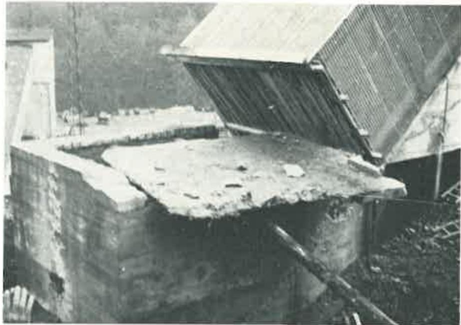
Bild 8. Seitliches Abziehen der losgesprengten Decke.
