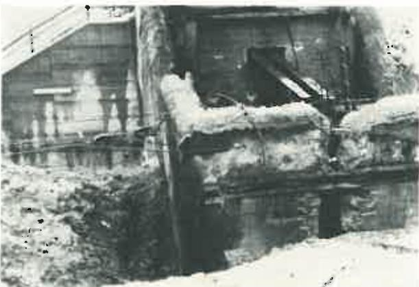
Bild 14. Vorkehrung zum seitlichen Abziehen des zweiten südlichen Oberteils.
