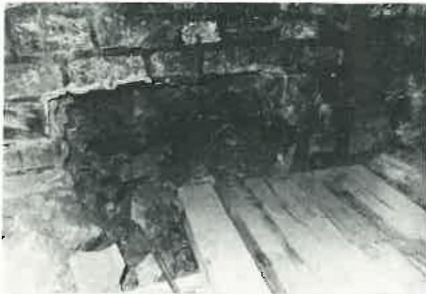
Bild 6. Ergebnis der Sprengung mit Doppelkeil-Einbruch.
