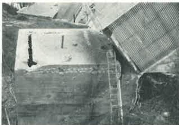
Bild 5. Erste Teilsprengung der Decke. (In der Mitte ein aufgestelltes Rundholz.)
