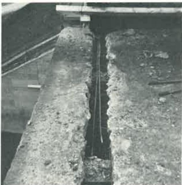
Bild 6. Ein nachgearbeiteter Sprengspalt.
