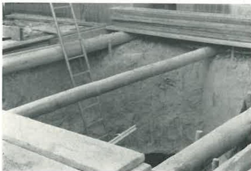
Bild 6. Oberer, bereits abgetragener Bereich eines Turbinenhalses.
